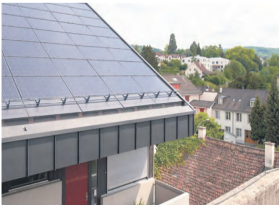
Alterssiedlung Drei Brunnen.
