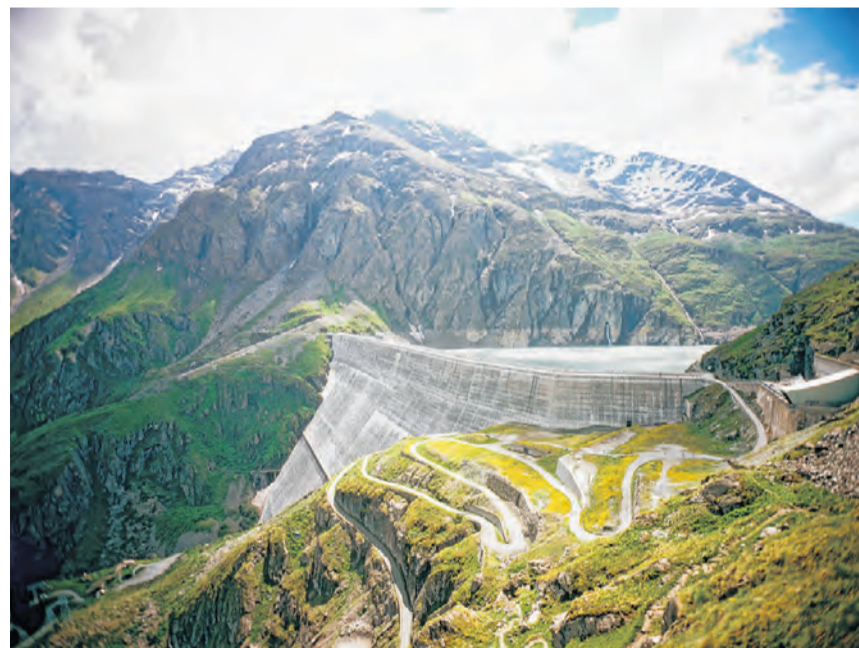
Die Staumauer der Wasserkraftwerksanlage Grande Dixence in den Walliser Alpen.
