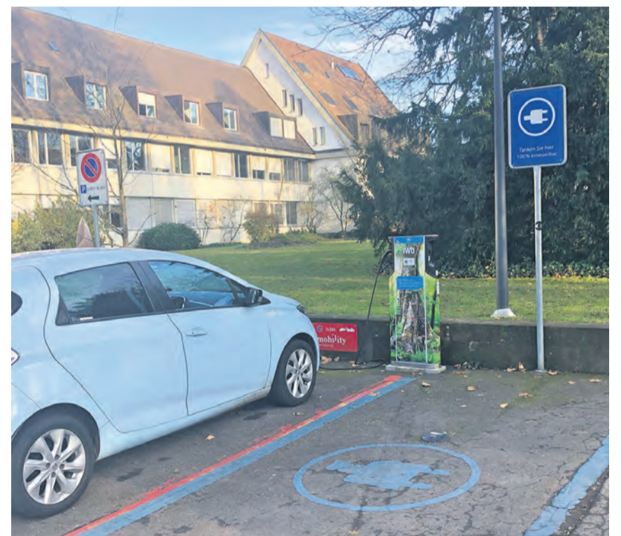
Öffentliche Ladestation beim Rieherer Gemeindehaus.
