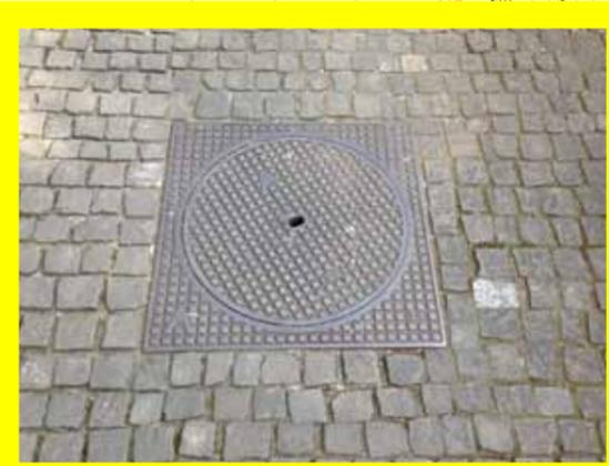
Schächte innerhalb der Pflasterung / Pflasterung Hauseingänge / Pflasterung Auframpungen (diverse Grössen) Gusdeckel mit eckigem Rahmen. Immer auf die Laufrichtung der Pflasterung ausgerichtet.
