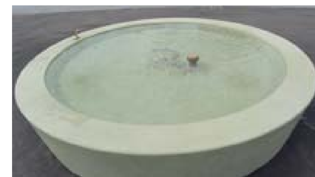
Fugenlose Sitzfläche Kalkzement
