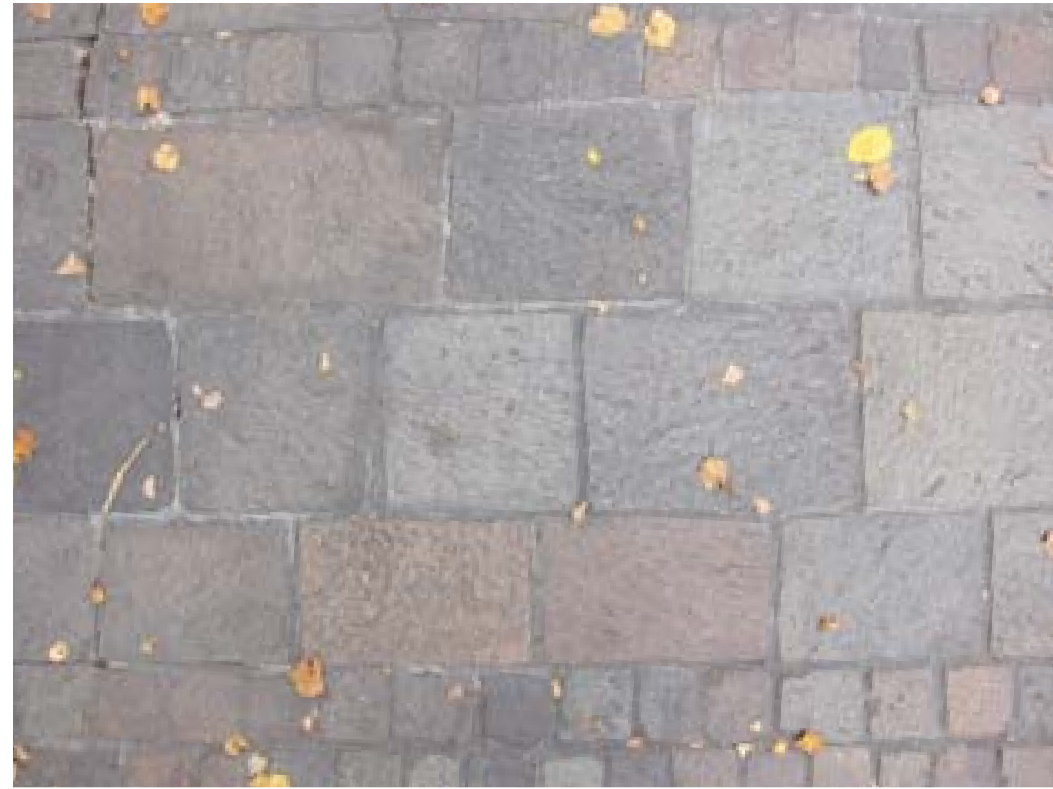
Webergässchen Porphyr Pflastersteine 12 x 12 cm und Platten diverse Grössen
