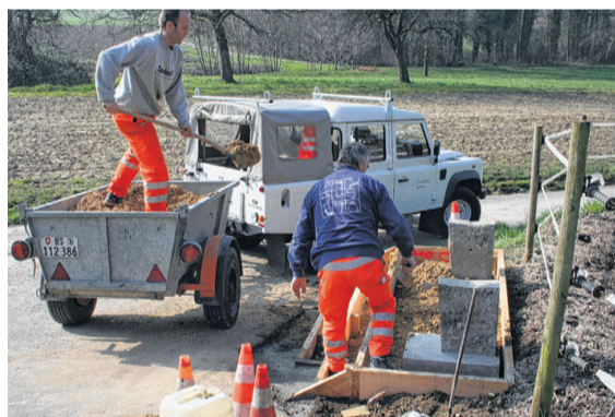
Mitarbeiter der Werkdienste stellen die Granitsockel bereit.
