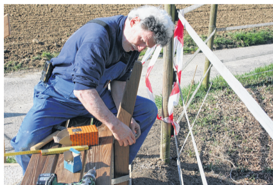
Die Sitzfläche und die Rückenlehne werden montiert.
