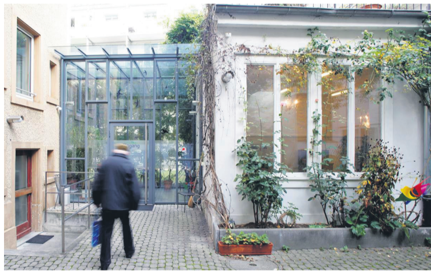
Die Tagesstätte im Atrium schafft mit Räumen für Entspannung und Kreativität eine Umgebung zum Wohlfühlen. Foto: zVg
